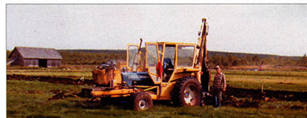
Harri (aina ekeyksissä) on löytänyt työmaalle ja liitosmonttu on syntynyt kokoojaojan varteen. Pelto ei ole kovin pehmeä, kun vastapainoja kaivurin nokalla ei ole pudotettu pois. Eikä teloja asennettu.
